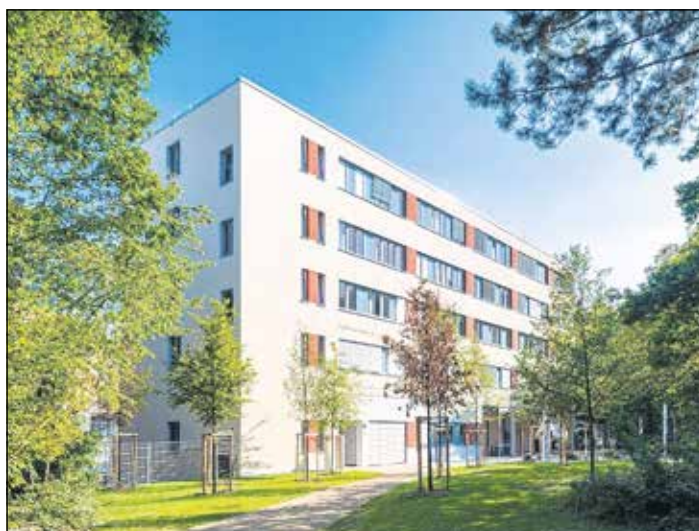
Die Hautmedizin Bad Soden im neu errichteten Ärztehaus auf dem Gelände der Main-Taunus-Kliniken
