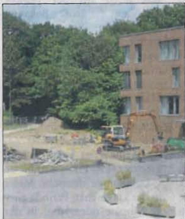
Der Bagger rollt: Das Ärztehaus entsteht neben dem jetzigen Klinik-Gebäude. Foto: Knapp
