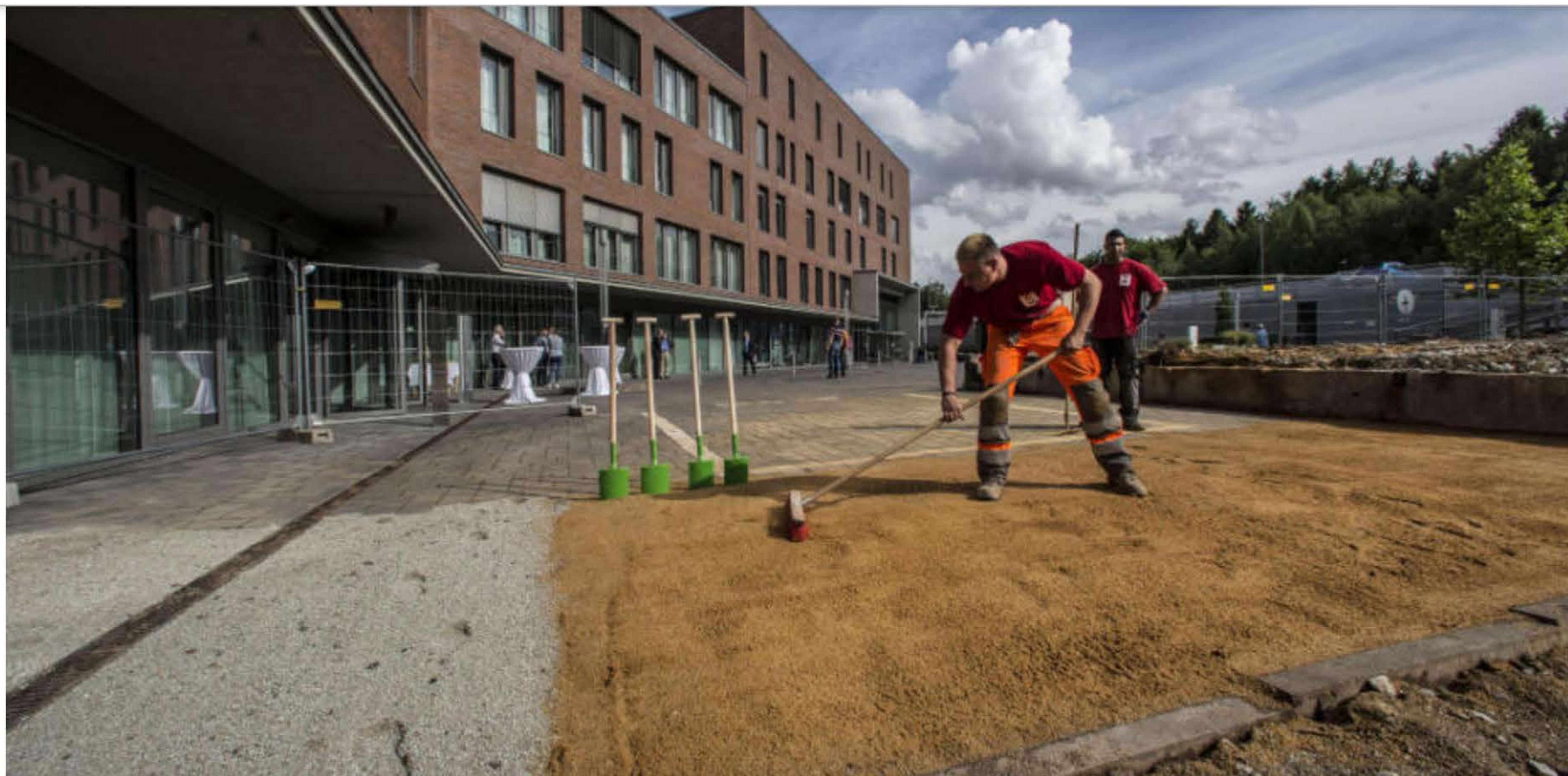
Letzte Vorbereitungen für den Spatenstich. Foto: Michael Schick
